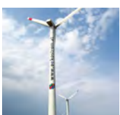
Parndorf Repowering (Österreich) 7,3 MW Leistung, in Betrieb seit 2023
