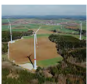
Frickenhofer Höhe 7,2 MW Leistung, in Betrieb seit 2016
