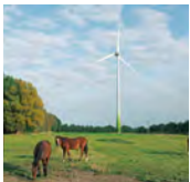
Roydorf 2,4 MW Leistung, in Betrieb seit 2009
