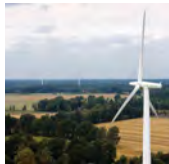
Soltau 3,9 MW Leistung, in Betrieb seit 2006
