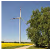
Langenbrügge 4,0 MW Leistung, in Betrieb seit 2010
