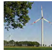
Sudenburg 6,0 MW Leistung, in Betrieb seit 2010
