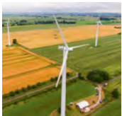
Uetersen 4,8 MW Leistung, in Betrieb seit 2001 (Repowering in Umsetzung)
