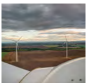
Wundersleben 6,0 MW Leistung, in Betrieb seit 2011
